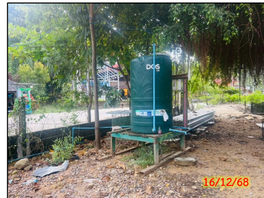
รูปที่ 2.2-4 ถังเก็บน้ำสำหรับอุปโภคของพนักงาน
